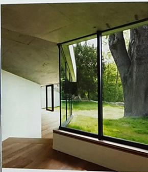
Le béton gris est apparent, à l'intérieur et à l'extérieur. La dalle de béton a une épaisseur de 25 cm pour des portées de 1,50 m à 8 m avec une toiture végétalisée, le tout intégré dans la pente du terrain.
