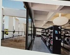
L'ensemble du bâtiment est réalisé en béton blanc coulé en place, apparent à l'intérieur comme à l'extérieur. La structure du bâtiment est composée de planchers à caisson, de poteaux poutres architectoniques et d'une enveloppe de doubles voiles en béton auto-plaçant. L'apparence de la peau du béton conserve l'empreinte rugueuse de son coffrage de planche de bois.
