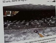
IDBAT - décoffrage en usine - béton très haute performance à base de ciment blanc et de fibres inox. Formulation établie par le CERIB.
