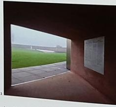
Les éléments préfabriqués sont en BFUP précontraints par post-tension. L'anneau est teinté noir dans la masse avec une lasure hydrofuge et l'entrée qui se fait par une tranchée a été réalisée en béton armé coulé en place, teinté ocre dans la masse et bouchardé à la main. Une matrice antidérapante a été utilisée pour les dalles de sol.
